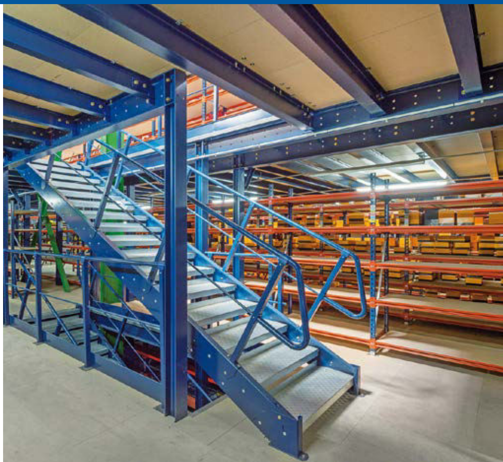
Bodenbelag aus Spanplatten mit Melaminbeschichtung MA/ML
